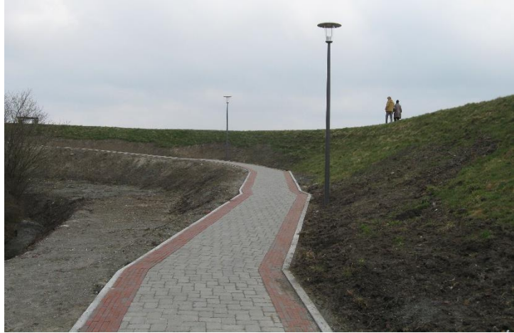
Blick auf den neu gestalteten Gehweg
